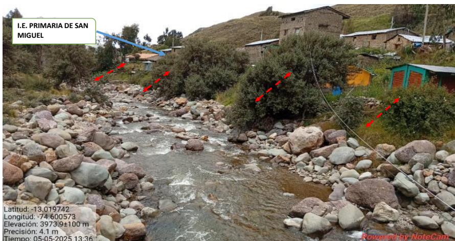
FIGURA N°03: TRAMO DE LA QUEBRADA HUANOPATA (RIO SAN MIGUEL), CON EL AUMENTO DEL CAUDAL EN SU CRECIDA DE LA QUEBRADA PUEDE LLEVAR LAS VIVIENDAS DE FAMILIAS, COMO LA INSTITUCION EDUCATIVA PRIMARIA DE SAN MIGUEL, POR ELLO SE REQUIERE LA PROTECCIÓN MEDIANTE MURO DE GAVIONES
